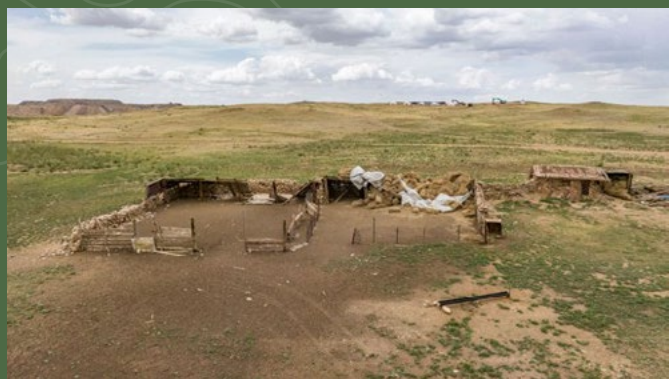
Photo 1: L’abri d’hiver de l’éleveur P. s’est effondré à cause des explosions provoquées par les huit compagnies minières voisines, rendant impossible l’entrée du bétail à l’intérieur.
